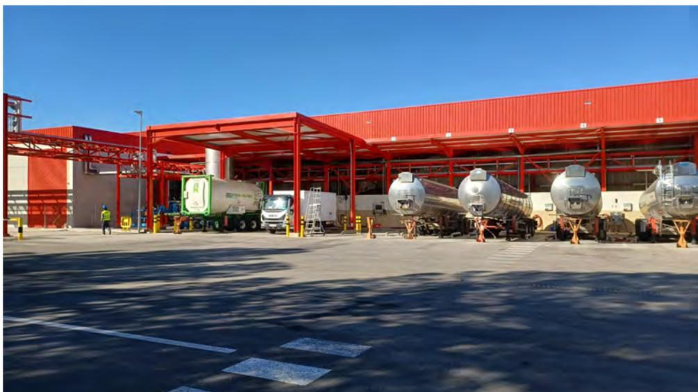
El llenado de cisternas se realiza desde la BBT de la planta de El Prat. Actualmente se tienen designados determinados tanques de la Bodega los cuales se conectan a un panel multivías desde donde la Cerveza es enviada a la instalación de llenado de cisternas a través de 2 líneas de servicio, lo que permite el llenado 2 cisternas simultáneamente.
