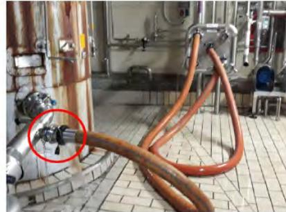
El llenado desde los tanques de la BBT pasa por un nudo de válvulas automatizado situado en la instalación de cisternas, que nos lleva a una de las 4 estaciones de llenado, desde donde se procede de manera directa al llenado de la cisterna, actualmente de una capacidad de 250 HI y 180 HI para la cisterna refrigerada.
