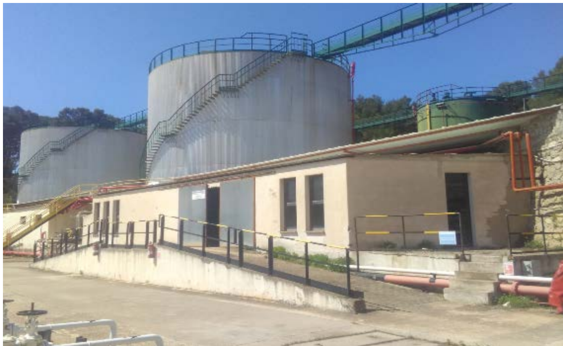
Fotografía 24. Nave material contra incendios con tanques de almacenamiento al fondo (Se desmantela y se traslada material a otra ubicación)
