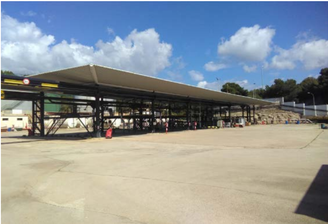
Fotografía 4. Cargadero de camiones cisternas
