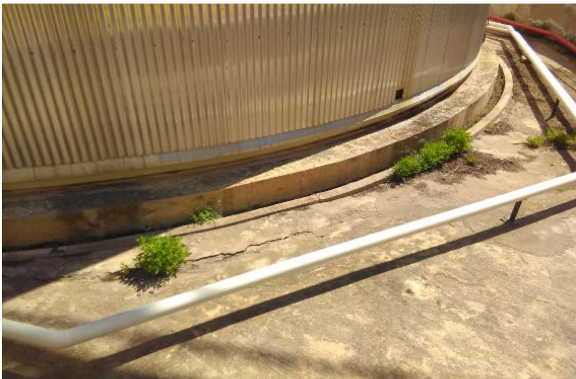
Fotografía 18. Cimentaciones tanque almacenamiento
