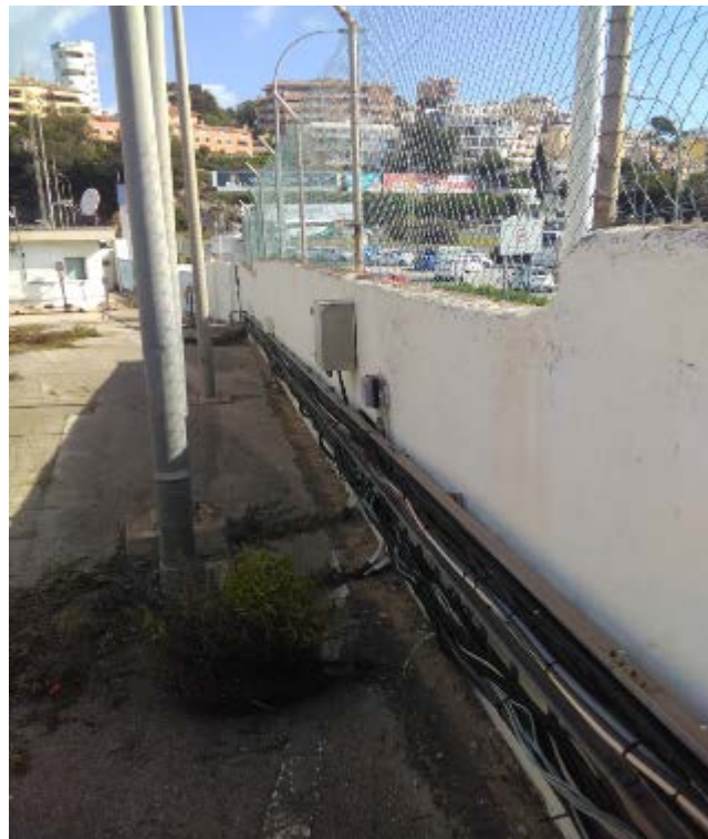
Fotografía 8. Muro cerramiento (No se desmantela)
