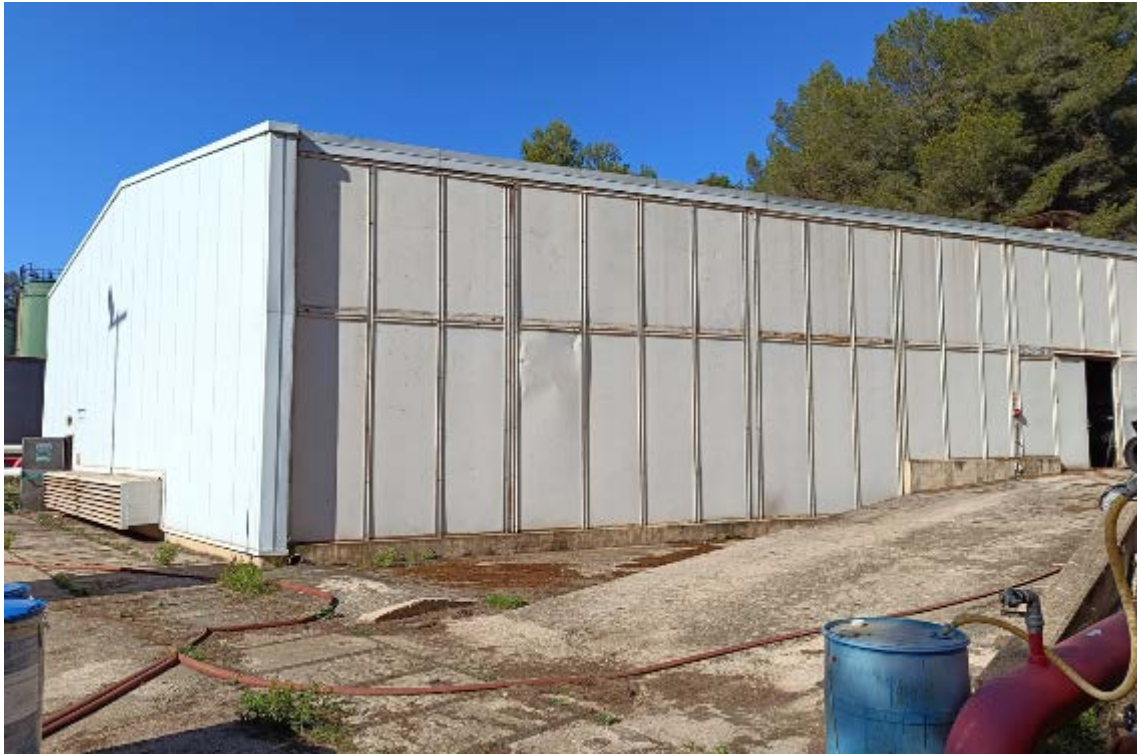
Fotografía 39. Estación bombeo poliducto (No se desmantela)
