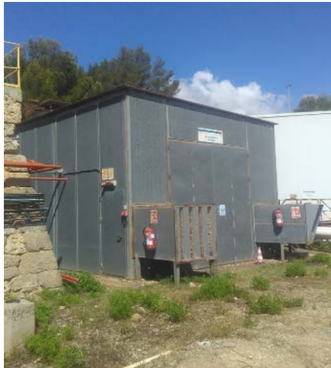
Fotografía 22. Nave bomba MBP-5 (No se desmantela)
