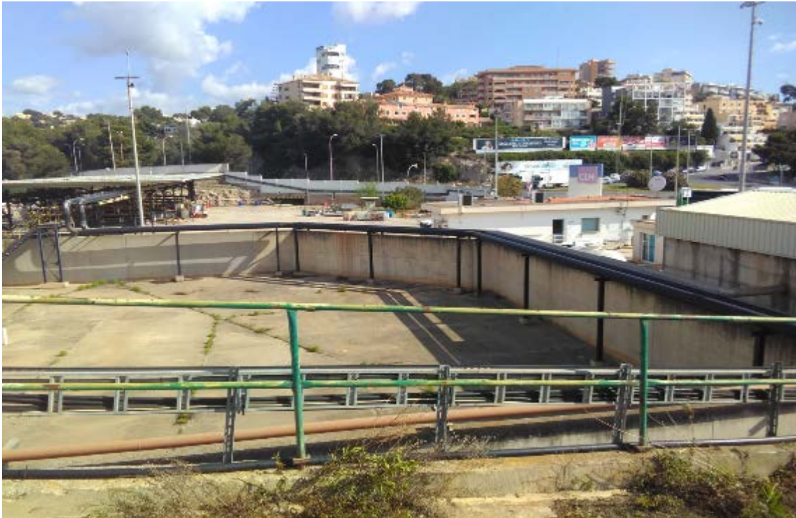
Fotografía 3. Parte del cubeto del tanque T-010 con cargadero y edificio de oficinas al fondo.
