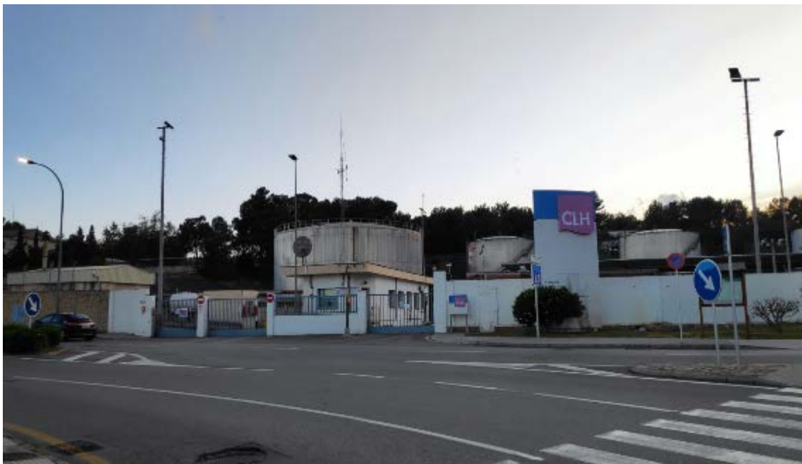
Fotografía 2. Acceso a la instalación (Vista exterior)
