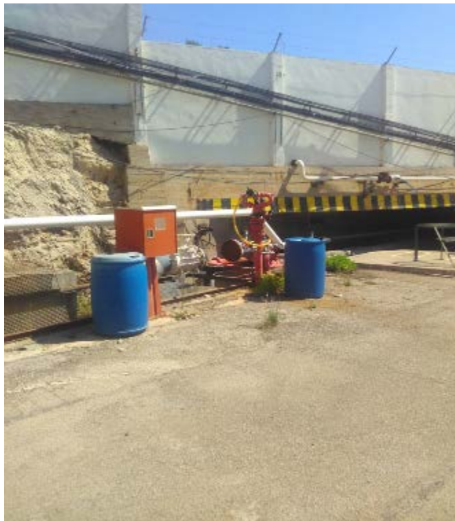
Fotografía 28. Entrada a galería poliducto fuera de servicio
