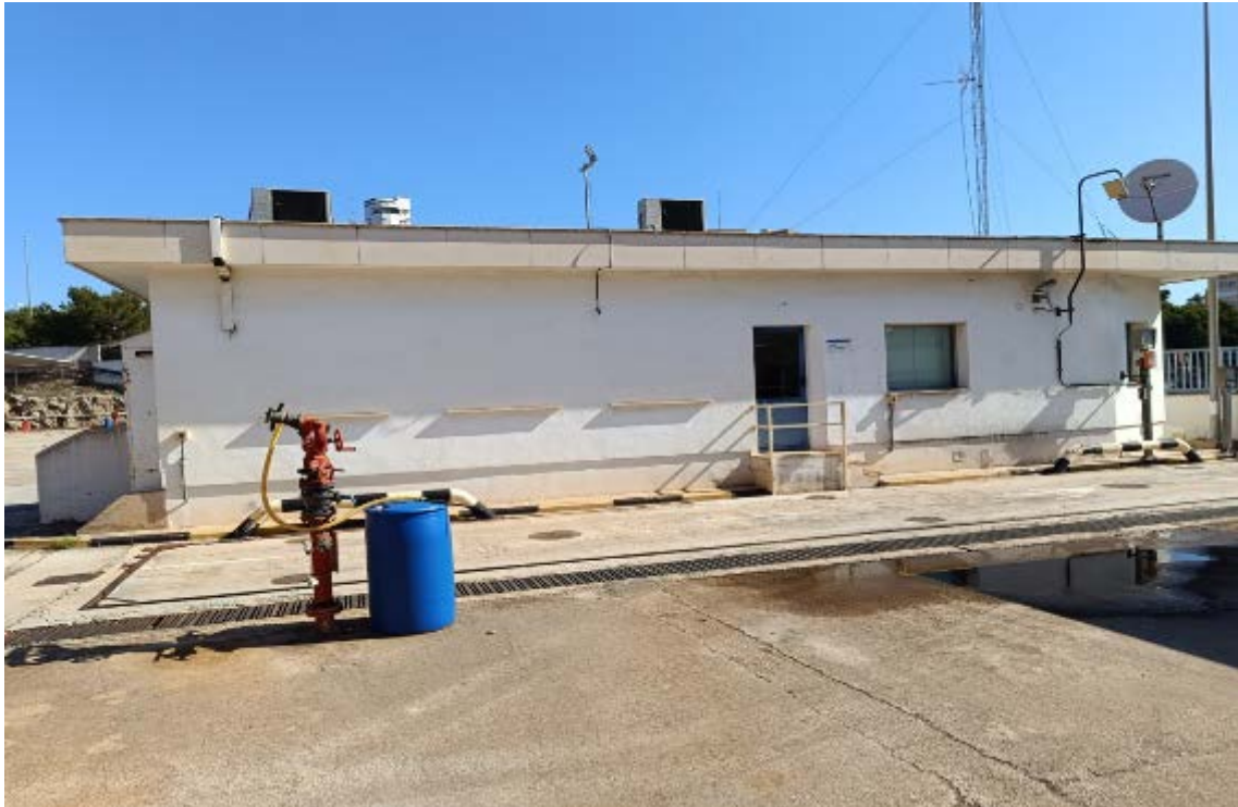
Fotografía 43. Edificio oficinas/Sala de control (No se desmantela)
