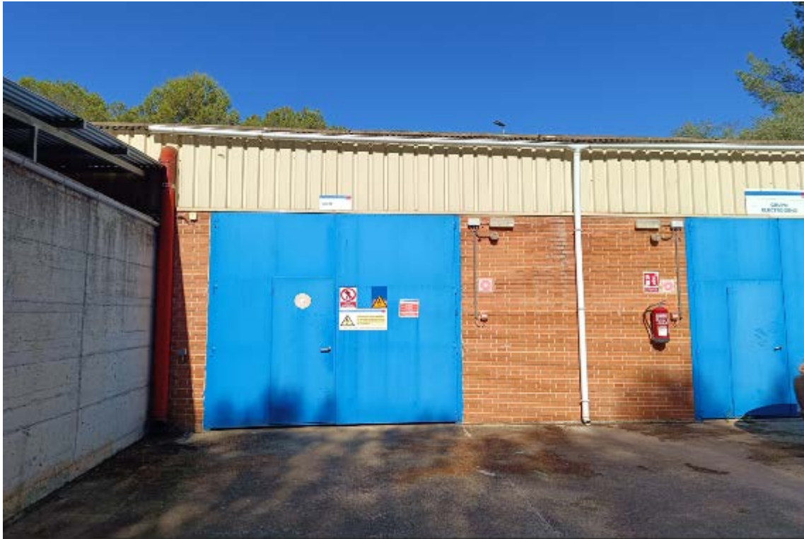
Fotografía 37. Centro de Control de Motores (CCM) (No se desmantela)
