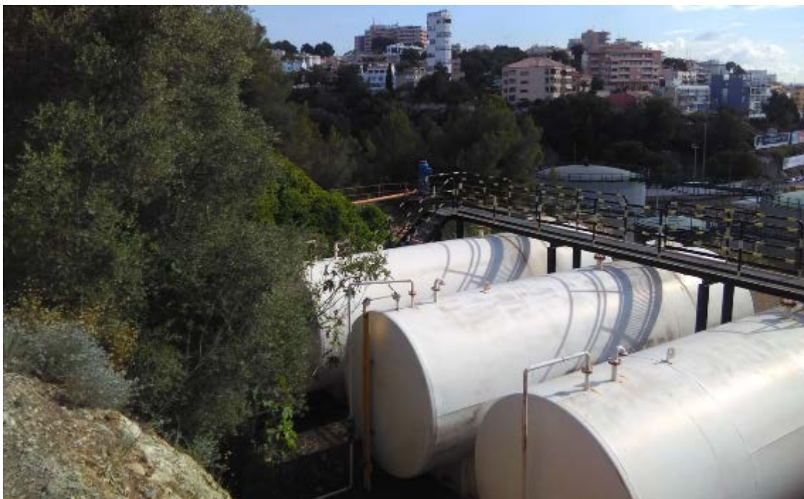
Fotografía 32. Antiguos depósitos agua DCI
