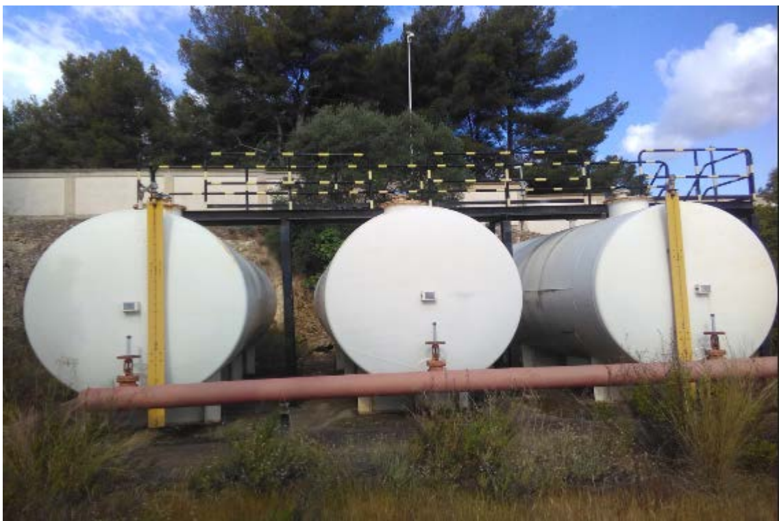
Fotografía 30. Antiguos depósitos agua DCI
