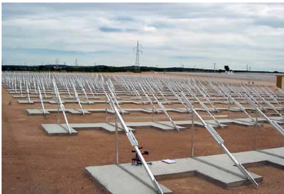
Soportes de hormigón sobre suelo rústico. Fuente: Fischer
