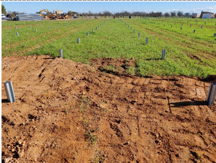
Hincado de soportes de acero galvanizado en el parque solar fotovoltaico Can Fuster (Santa Maria del Camí).
