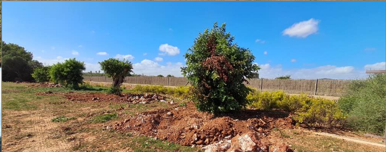
Fotografías de las actuaciones de adecuación de muros y saneamiento de la vegetación arbórea.
