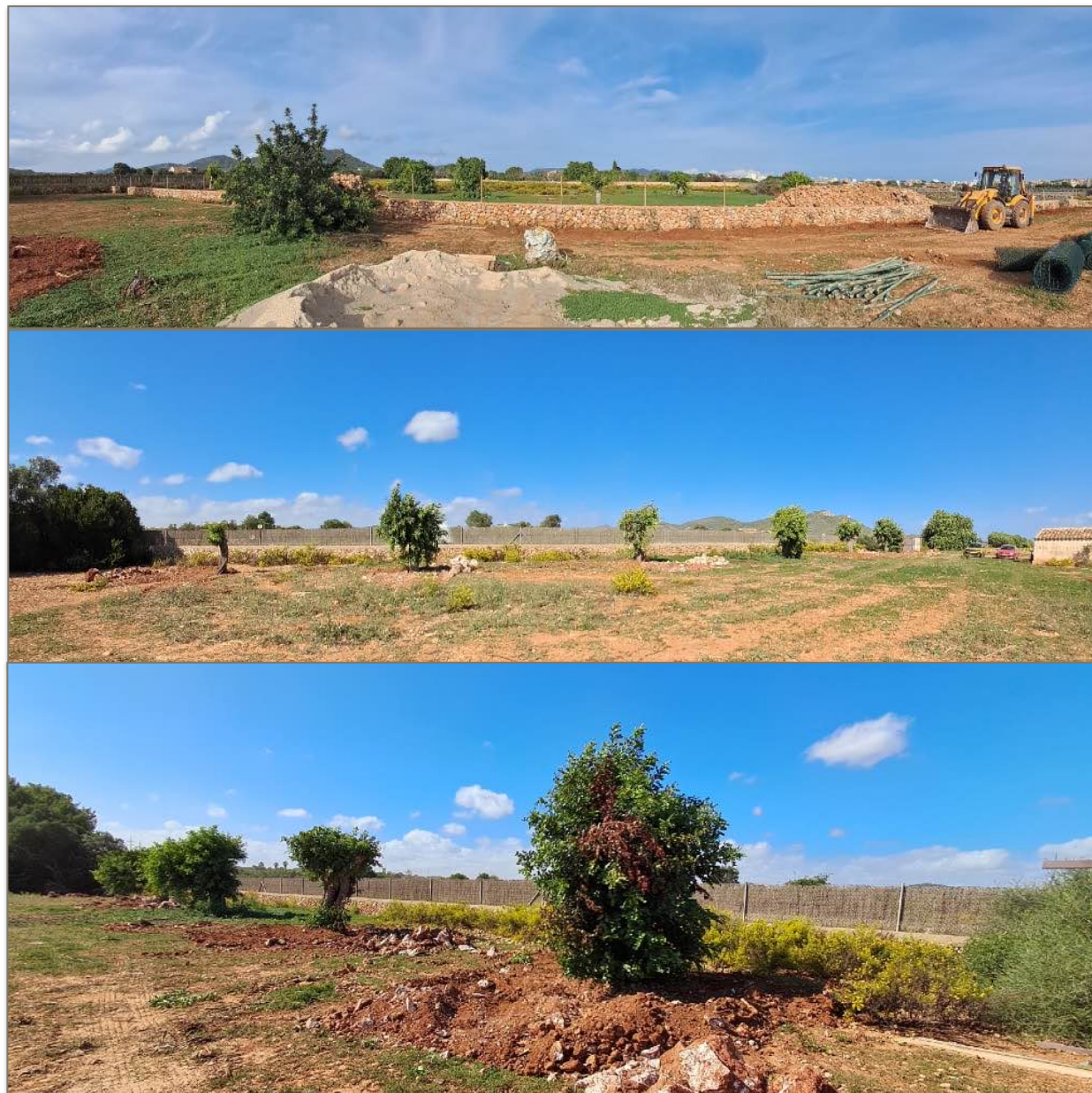
Fotografías de las actuaciones de adecuación de muros y saneamiento de la vegetación arbórea.
