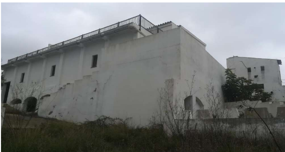
Figura 46: Fotografia façana sud edificació agrícola 4
