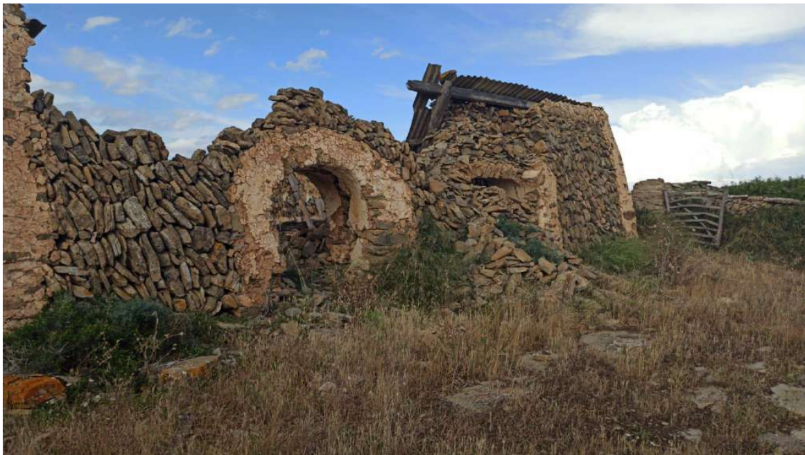
Figura 35: Estat actual bouer 3. Façana sud.
