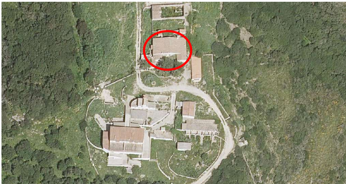
Figura 26: Edificació principal Son Rubí - habitatge (ortofoto 2018)
