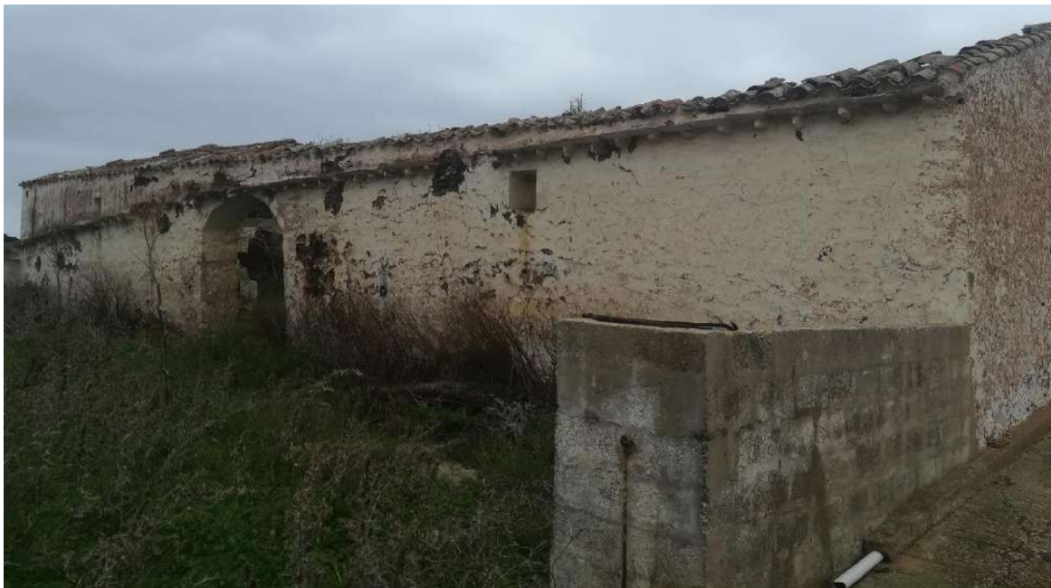
Figura 29: Estat actual bouer 1. Façana sud.
