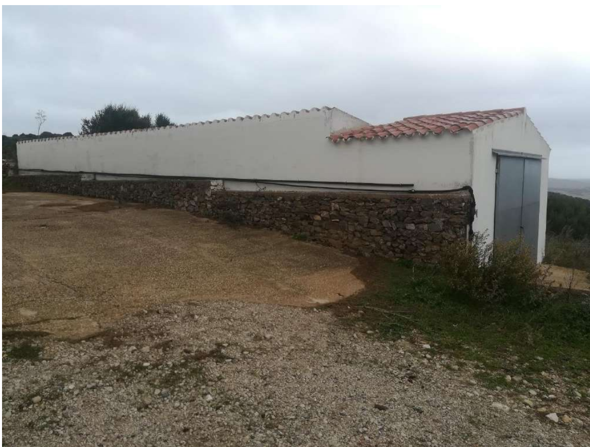
Figura 38: Façana oest i sud edificació agrícola 3
