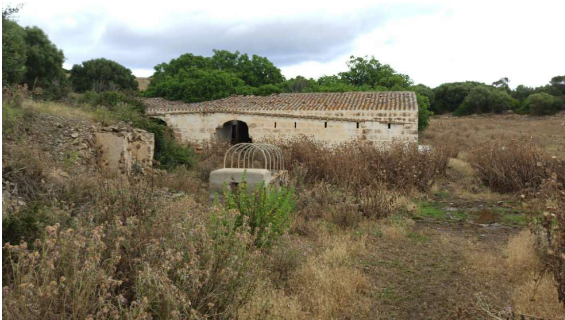
Figura 33: Estat actual bouer 2. Façana sud.
