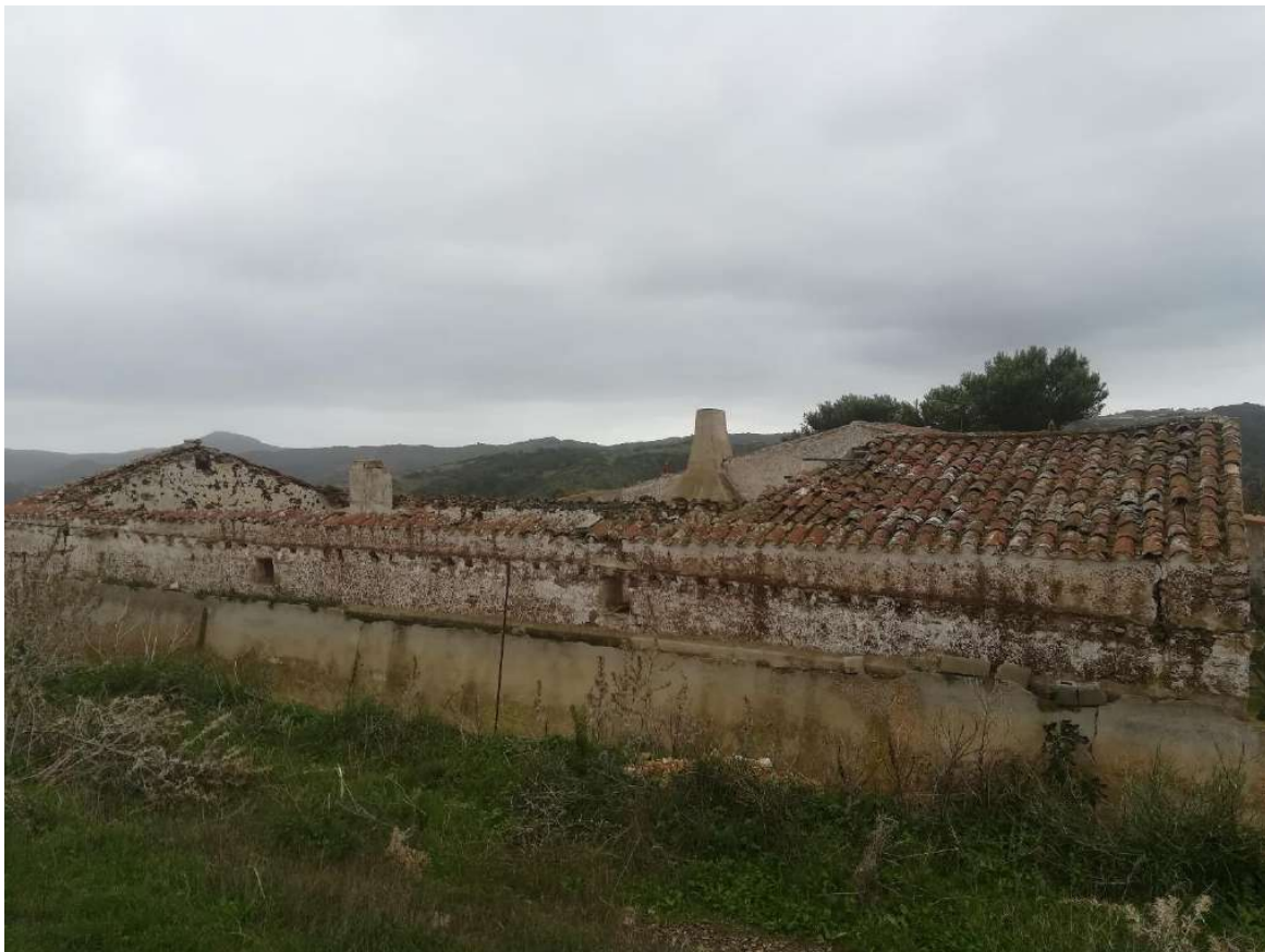
Figura 31: Estat actual boer 1. Façana nord.
