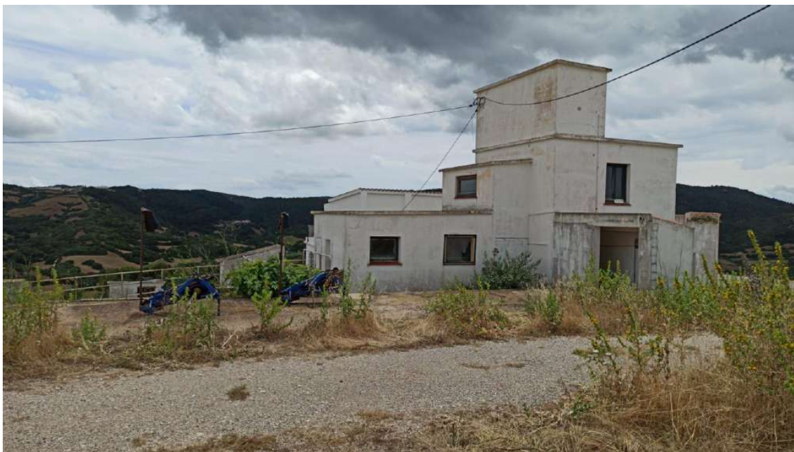
Figura 43: Estat actual edificació agrícola 3. Façana nord.
