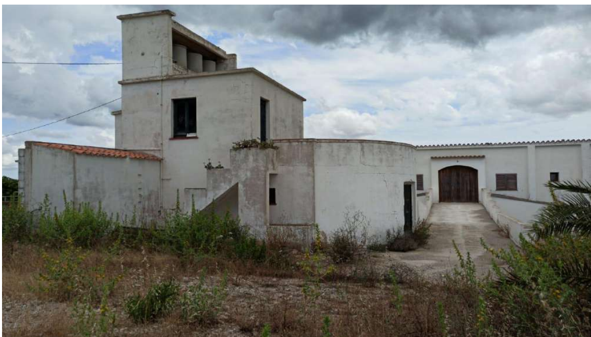
Figura 44: Estat actual edificació agrícola 3. Façana nord.
