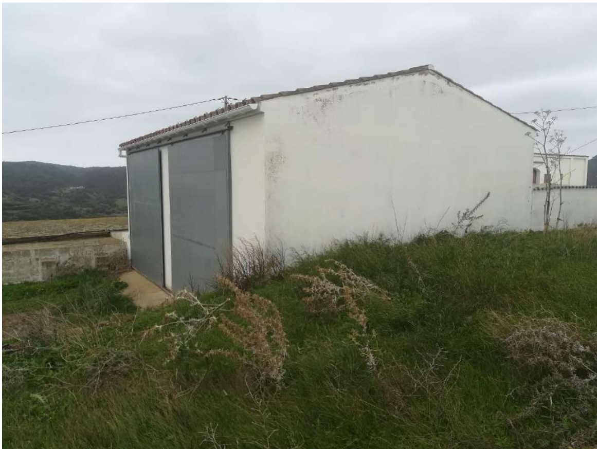
Figura 41: Estat actual edificació agrícola 2. Façana nord.
