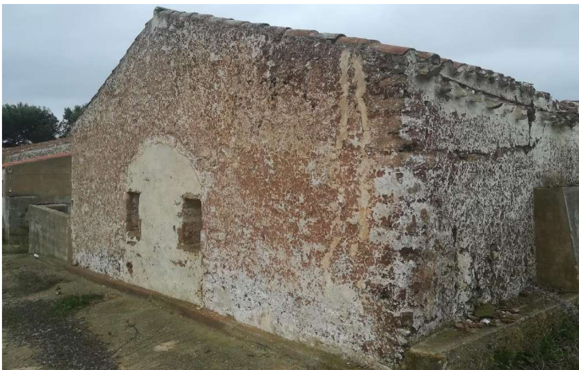
Figura 30: Estat actual bouer 1. Façana est.
