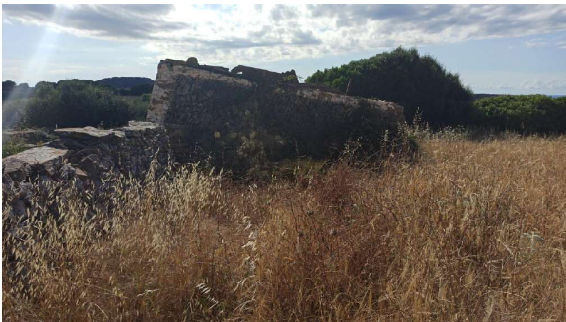
Figura 36: Estat actual bouer 3. Façana est.
