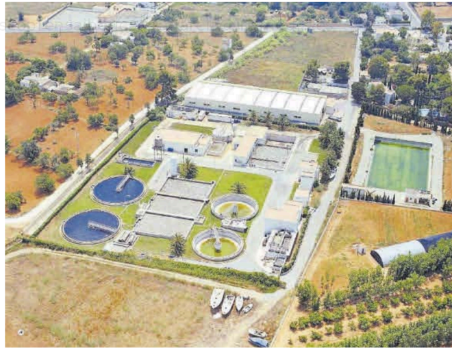
Depuradora de Santa Eulària. | CAIB
