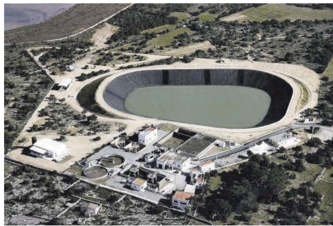
Depuradora de Formentera. | CAIB
