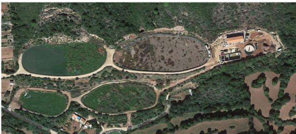
Imagen aérea de la antigua depuradora de Ferreries y de los lodos contaminantes procedentes de la misma
