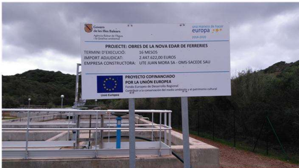
Cartel informativo de las obras de construcción de la nueva depuradora de Ferreries
