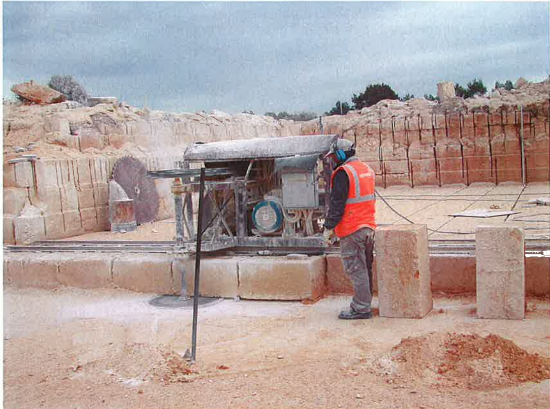
FOTOGRAFIA 5: Otra vista del corte vertical y horizontal
