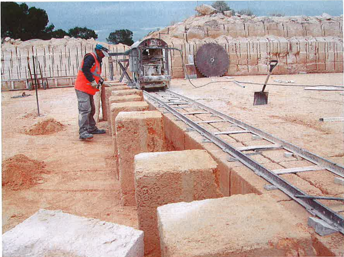
FOTOGRAFIA 6: Detalle de los bloques finales y colocación de la vía.
