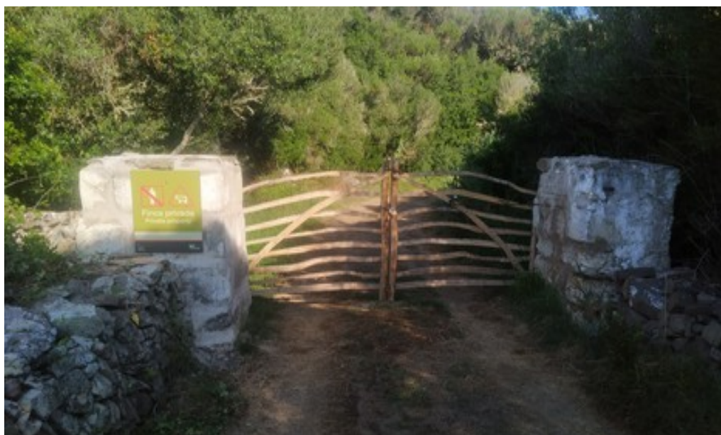
Foto 28. Rehabilitació de barreres d'entrada
