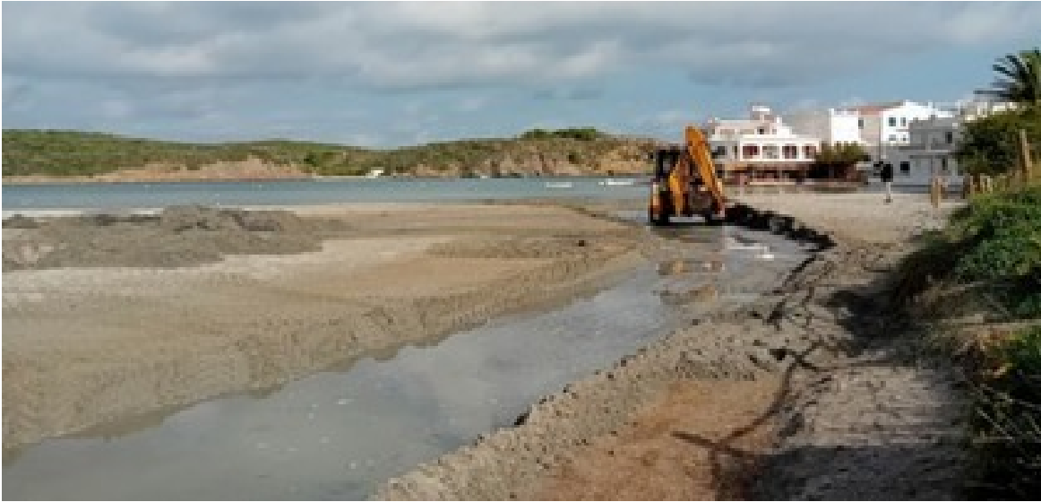
Foto 21. Treballs d'obertura mecànica de sa Gola.
