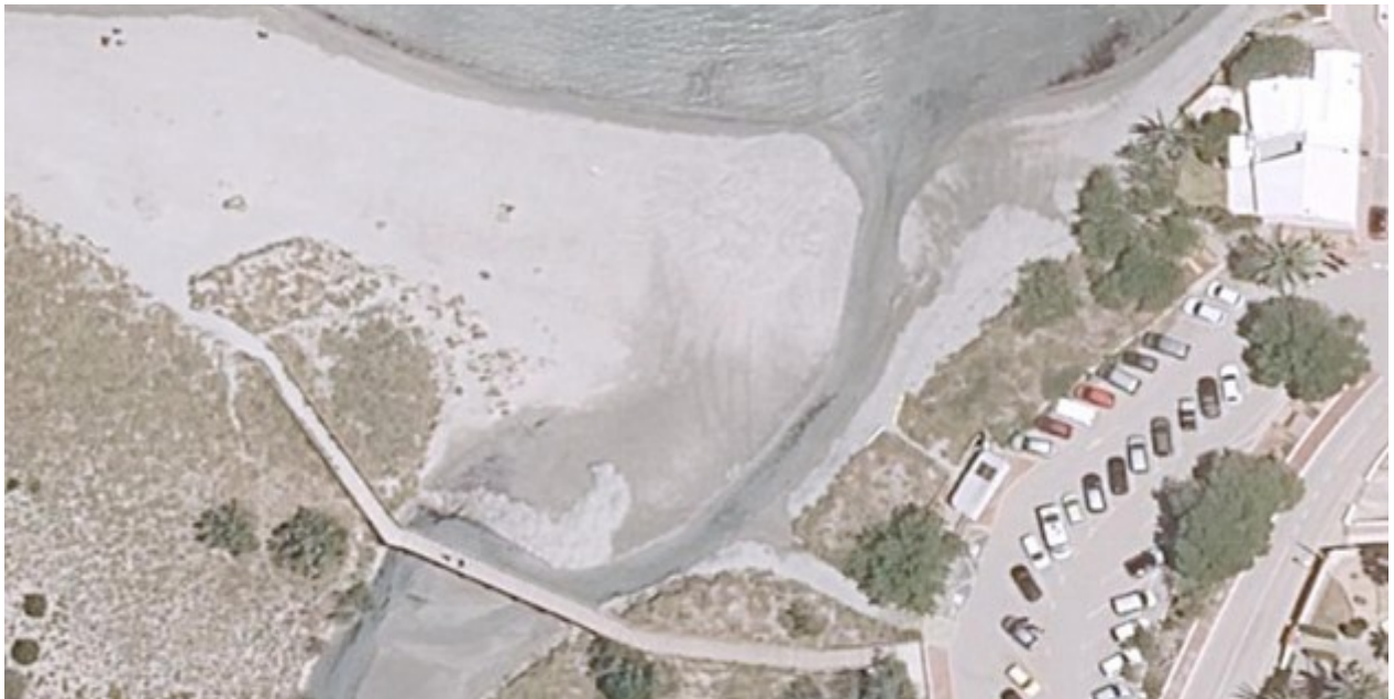
Figura 12 . Imatge aèria de finals de maig de 2024, just després de la primera obertura de sa Gola.
