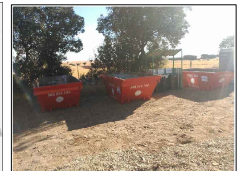
CONTENEDORES DE OBRA
