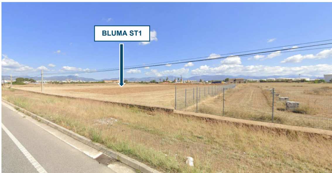
Ilustración 1.- Visibilidad de las baterías de almacenamiento desde la carretera Ma-5011. Fuente: Google Maps.
