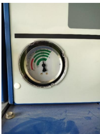
Manómetro indicador del nivel del Gas SF 6
