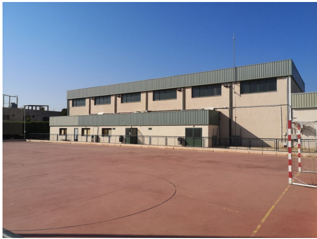
Fachada principal edificio anexo administrativo
