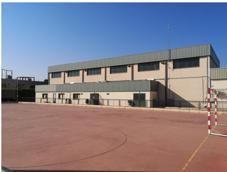
Fachadas este y norte del edificio anejo
