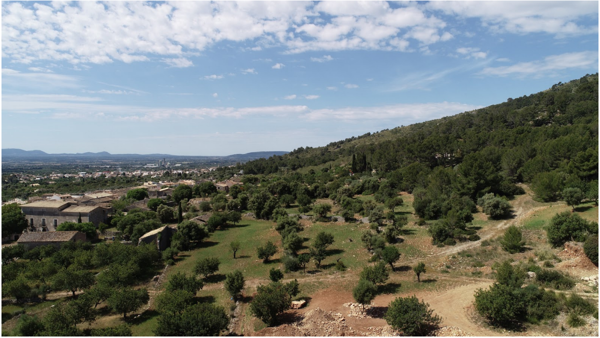
Figura 21. vista del punto 1. Fuente propia.
