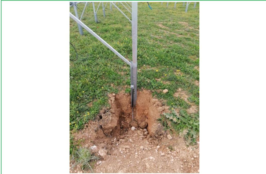
**Imagen.** Tornillos o estacas de fijación
